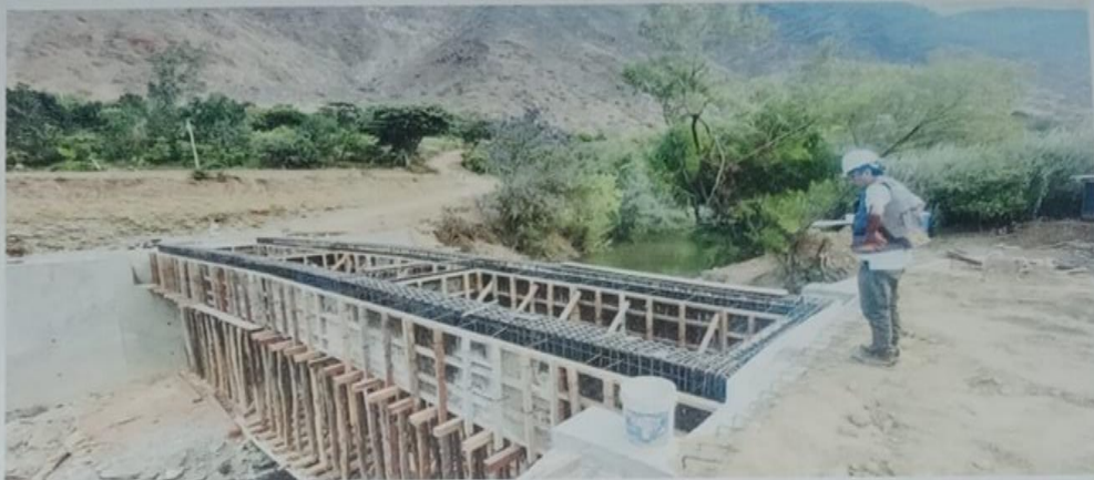
Fotografía N° 19: Encofrado de vigas principales y vigas diafragmas
